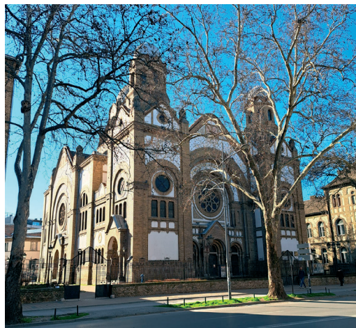
Sinagoga u Novom Sadu
